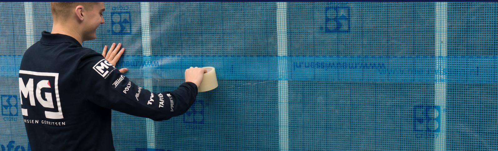
**VASTR® Film adhésif basique est un ruban adhésif simple face pour le scellement étanche au vent et à l'eau des joints de chevauchement et la réparation des dommages. Le film adhésif VASTR® basique est pourvu d'une maille de renforcement qui le rend très résistant et facile à déchirer.**
